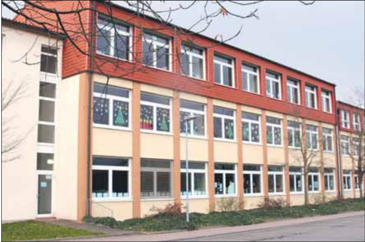
Auch wenn die alten Heizkessel noch funktionieren: Die Scholl-Schule erhält ein Blockheizkraftwerk. Foto: Frenzel
